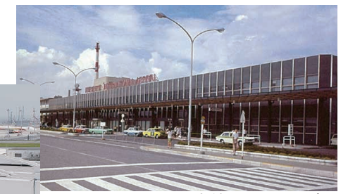
旧国際線ターミナルビル
